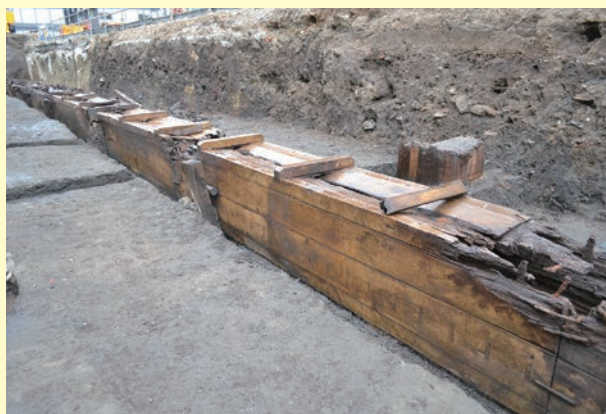
玉川上水の木樋
