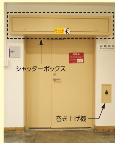
3階図書室入口 上部の箱がシャッターボックス。右手壁面にシャッターの巻き上げ機構が残されている。
