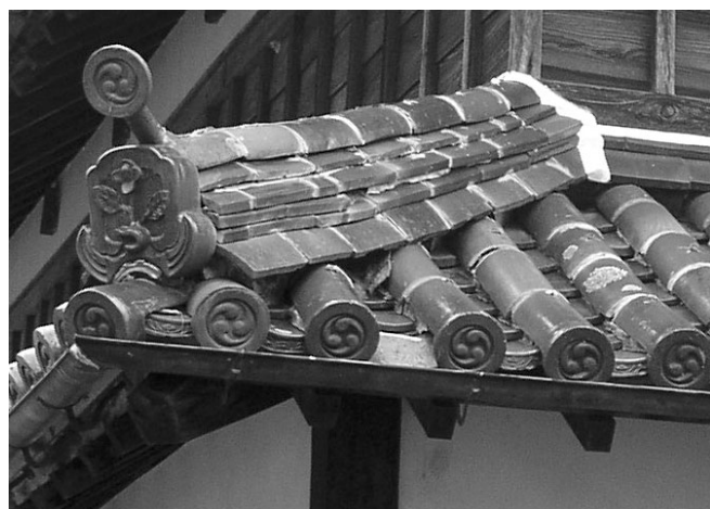
写真1 石見瓦の葺かれた櫓建物(部分) (島根県鹿足郡津和野町内)
