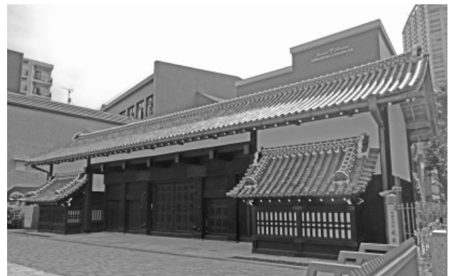
「武家屋敷門」外観(平成29年9月撮影)
