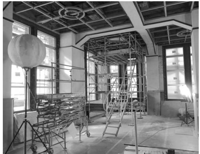
工事中の旧図書閲覧室
