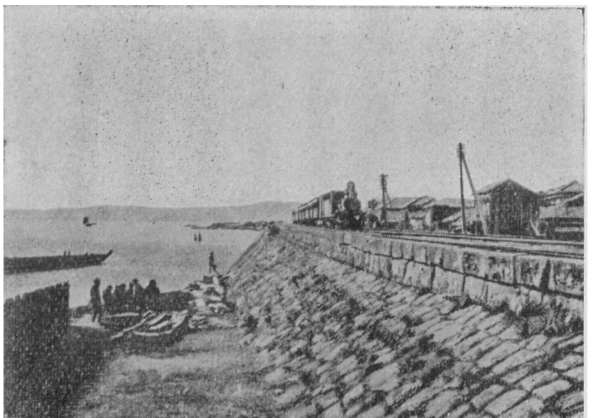
明治40年頃の田町付近の写真。石積みが確認できます。
