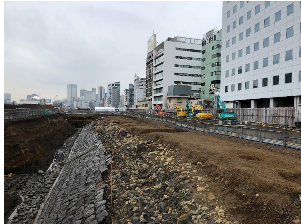
写真1 海側の石垣。写真右側築堤の上部にはバラストが残されています。
